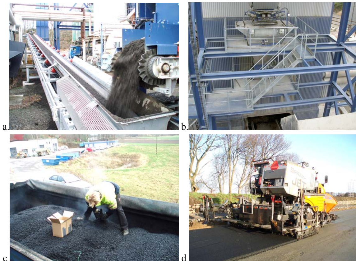
Bild 3-15 Provtagningsställen: RA/FRA efter inlastningsfickan (a.), efter parallelltrumman genom inspektionsluckan i vågen före blandaren (b.), efter utlastning (c.) och slutligen i asfaltläggarens breddökning ute på vägen (d.).
