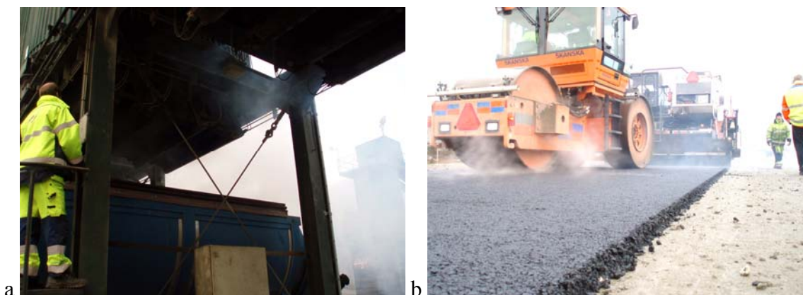
Bild 3-19 Röken från Nytex 820 märktes tydligt vid lastning och lossning, som berodde på hög temperatur i massan. När massan svalnade minskade rökutvecklingen och kunde till slut inte skiljas från vattenångan från vältarna.
