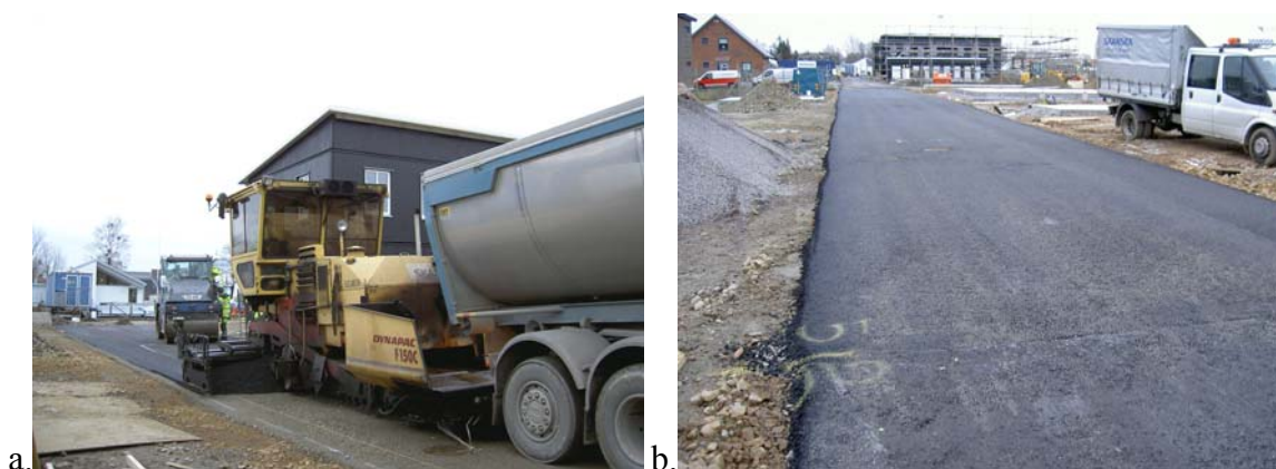
Bild 3-14 Provytan i Tygelsjö med ett lager asfalt på bärlagergrus.
